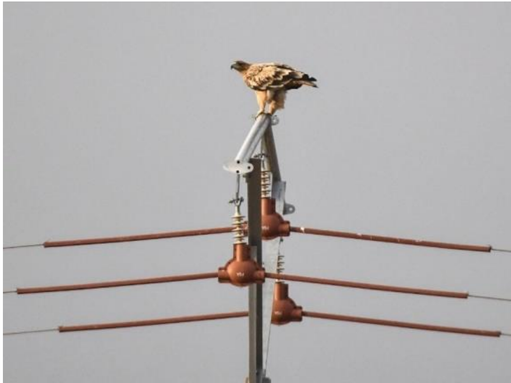
Imagen 3. Águila imperial ibérica posada sobre un apoyo eléctrico debidamente equipado con elementos aislantes, lo que le confiere una gran seguridad para las aves.
