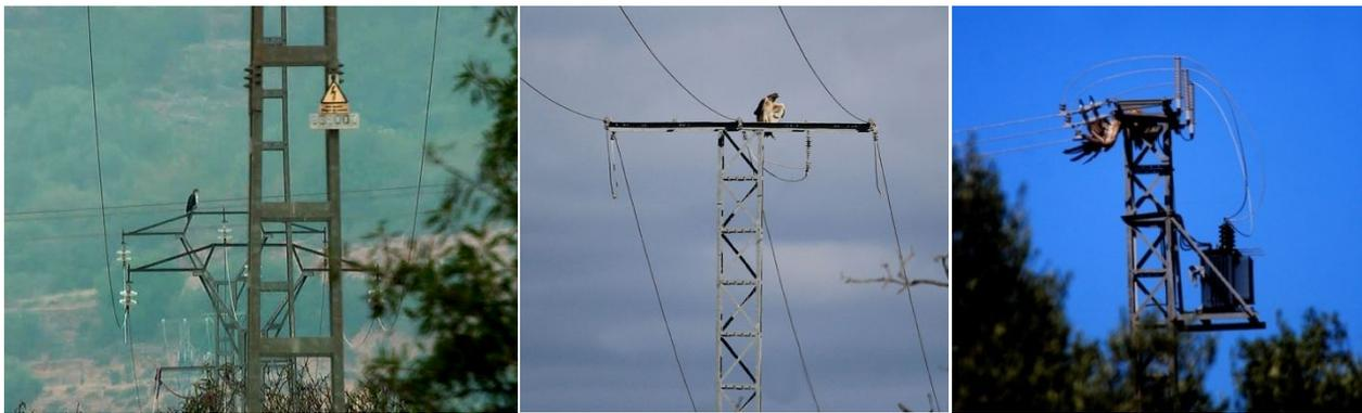
*(1) izquierda forma bóveda con aisladores suspendidos, (2) centro tipo T y cadena de amarre, (3) derecha. Transformador con puentes por encima de la cruceta.*
