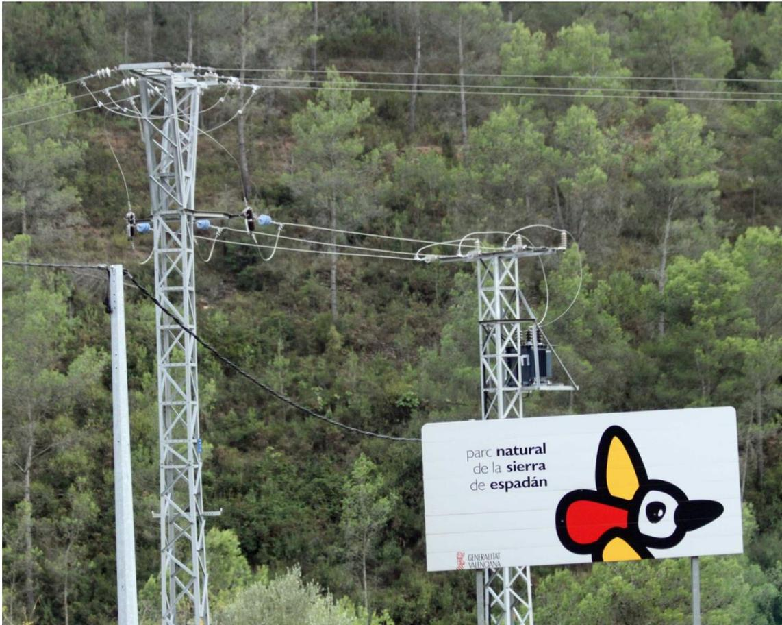
*Instalación de tendido eléctrico en el desvío Ayodar a Torralba del Pinar, sin colocar las medidas antielectrocución / anticollisión (Foto Leopoldo Pérez)*
