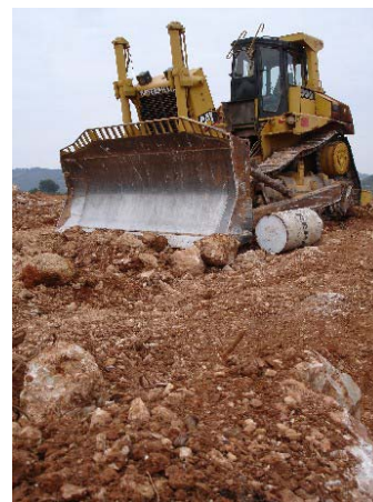
Trabajos y vertidos
