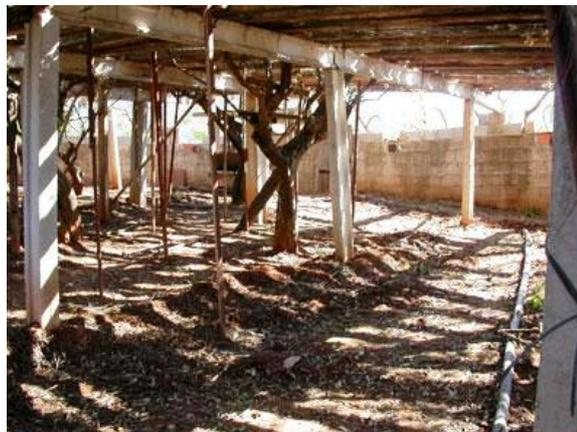
*Andamio construido con pilares y vigas de hierro y cemento*
