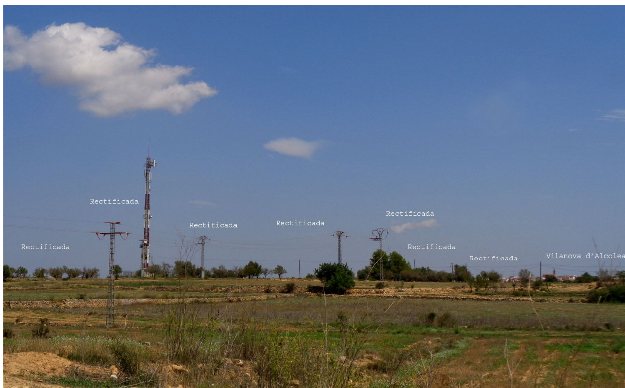
Foto general de un grupo de torres rectificadas en la zona de estudio.
