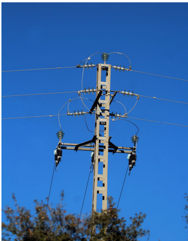
Torre de cruz con aisladores verticales y derivaciones. Torre CS 64894. Donde localizamos 7 cadáveres (1 paloma, 3 cuervos, 1 buitre, 1 ratonero, 1 milano negro), antes de ser rectificada.
