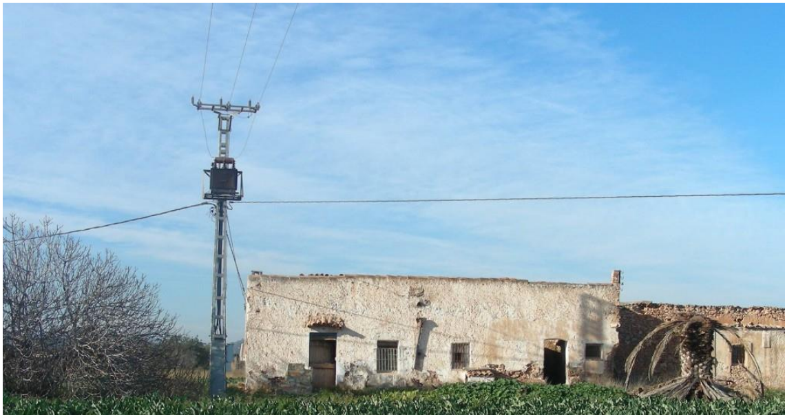
Línea eléctrica que causó la muerte del buitre negro por electrocución (localidad de Torreblanca, Castellón).
