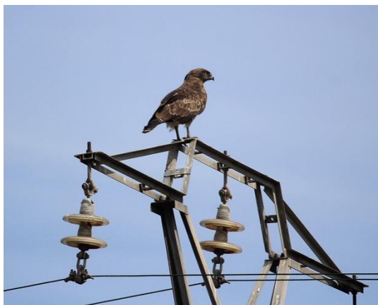
Aisladores en cadena y aisladores suspendidos.
