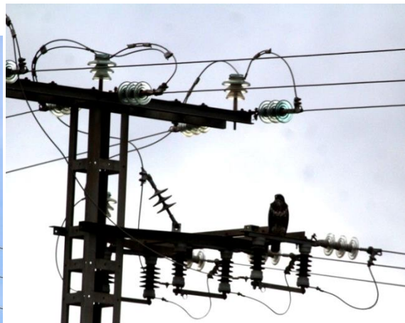
Cruceta en horizontal. Aisladores rígidos y en cadena
