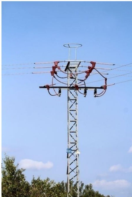
Torre rectificadora después de electrocutar a 2 águilas perdiceras adultas en 2010 y 2011. Vilanova d'Alcolea
