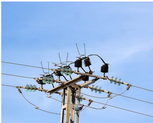
Cruceta en horizontal. Aisladores rígidos y en cadena
