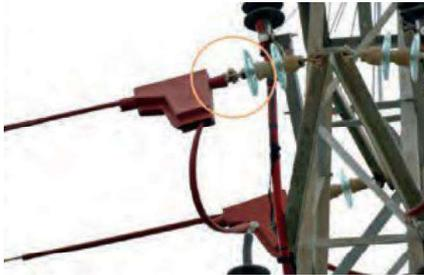
**Forrado o aislamiento roto e insuficiente distancia de seguridad en el amarre:**
