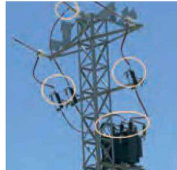
**Instalación defectuosa por no uso de materiales compactos específicos que terminan dejando elementos metálicos al descubierto:**
