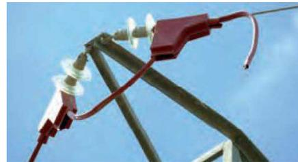
**Elementos de aislamiento desplazados al no haberse sujetado bien o al no haberse usado materiales correctos o específicamente diseñados para la protección de avifauna:**
