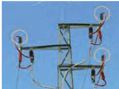
**Conexiones de fusibles al descubierto:**
