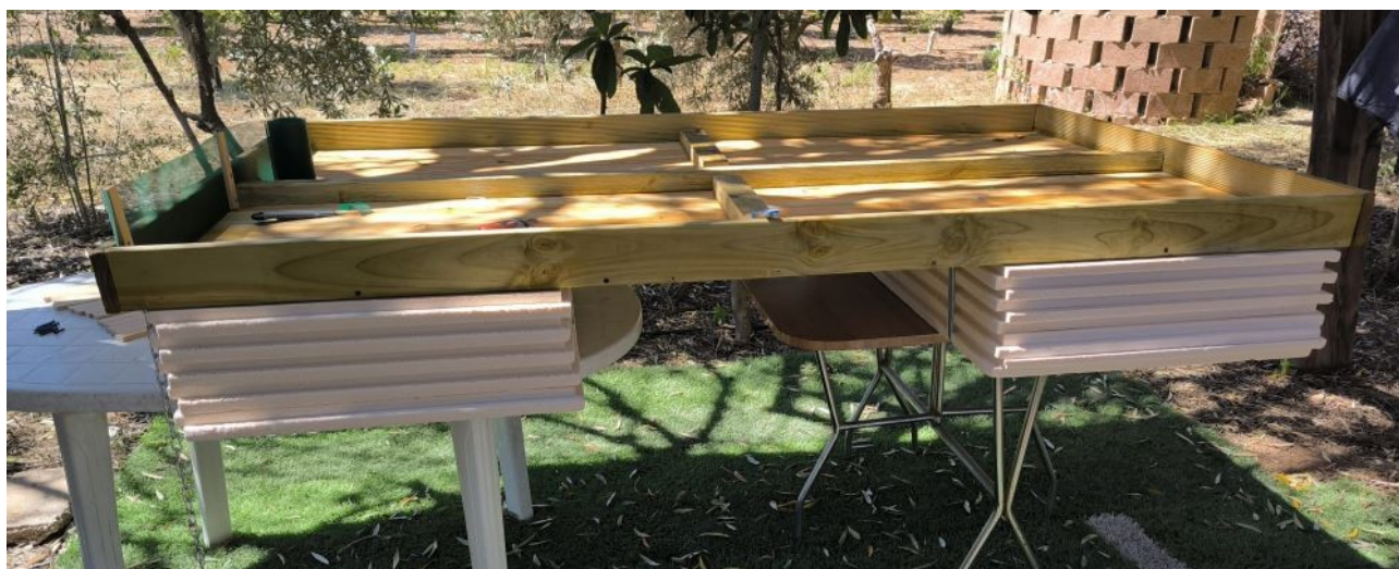
Voluntarios del GER realizando la plataforma flotante del proyecto. 1704/2025. Vila-real.
