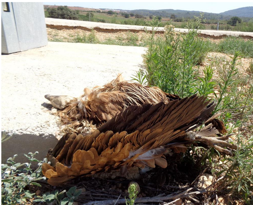
Electrocución buitre leonado. 02/08/2018. Benlloch (Foto GER)
